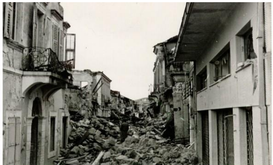
Εικόνα 7 . Ζάκυνθος, Αύγουστος 1953, μετά τον καταστροφικό σεισμό.
