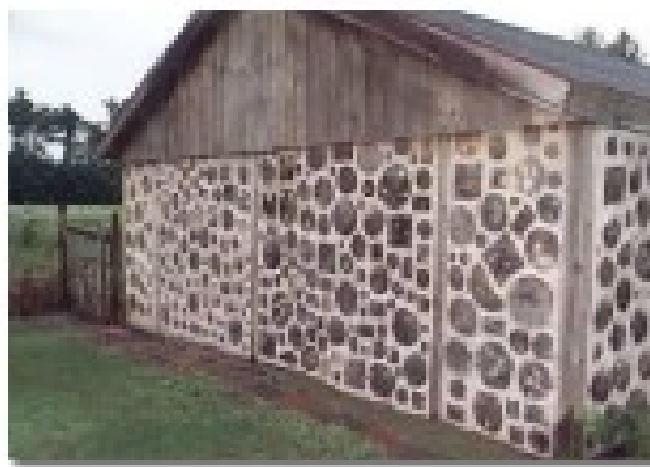
Εικόνα 182: Οικοδόμηση τοίχων με κορμούς καυσόξυλων (Πηγή: Λιόλιος, 2019)
