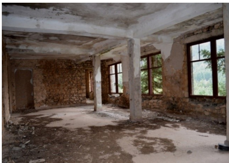
Εικόνα 93: Γερασμένο κτιριακό απόθεμα και κενά/ εγκαταλελειμμένα κτίρια
