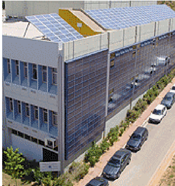
Εικόνα 129: Φωτοβολταϊκό σύστημα στην όψη της σχολής Χημικών Μηχανικών ΕΜΠ
