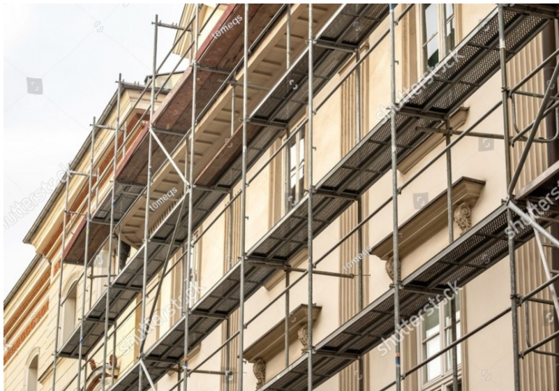
Εικόνα 107: Συνολική Ανακαίνιση κτιρίων
