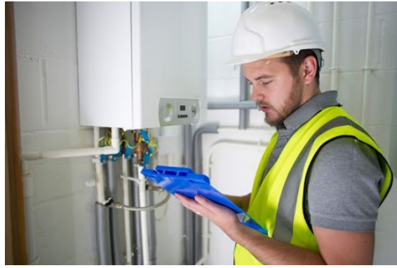
Εικόνα 199: Κατάρτιση εργατών και τεχνιτών σχετικά με κατασκευές και συστήματα εξοικονόμηση ενέργειας
