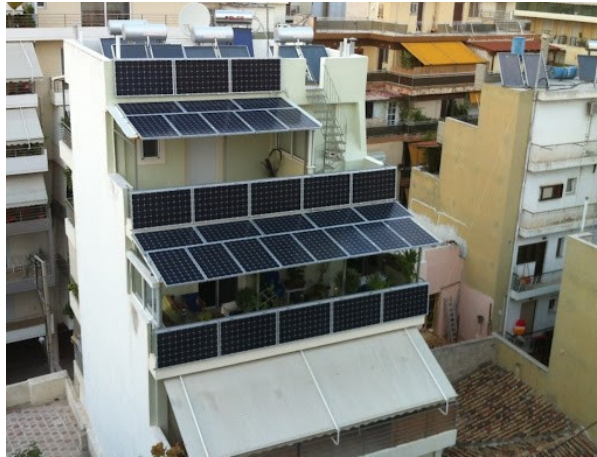
Εικόνα 110: Ενεργειακή αναβάθμιση κτιρίου
