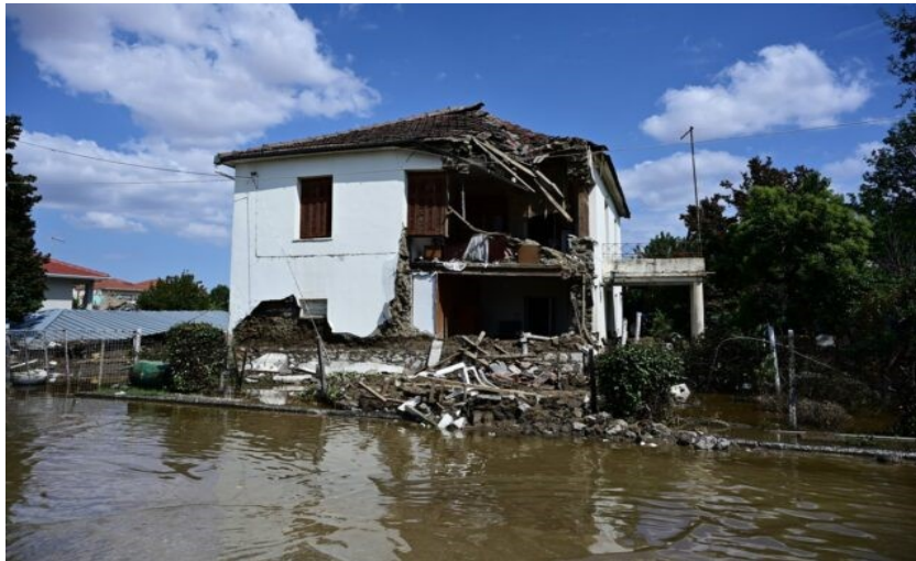
Εικόνα 105: Κτίρια και πλημμυρικά φαινόμενα
