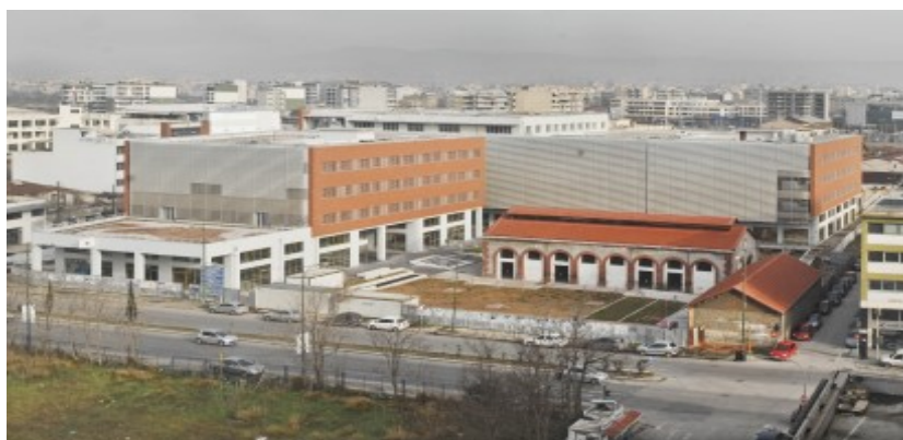
Εικόνα 128: Ενεργειακή αναβάθμιση κτιρίου Περιφέρειας Κ. Μακεδονίας με γεωθερμικές αντλίες θερμότητας
