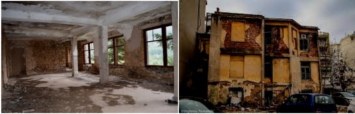
Εικόνα 99: Γερασμένο κτιριακό απόθεμα και κενά/ εγκαταλελειμμένα κτίρια
