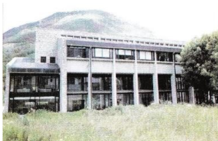
Εικόνα 149: Ενεργειακά αναβαθμισμένο νοσοκομείο Vielha Catalogne , Πυρηναία Όρη, Ισπανία
