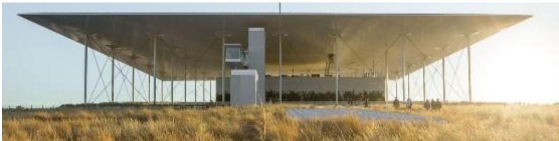
Εικόνα 128: Φυτεμένα δώματα στα κτίρια του ΚΠΙΣΝ
