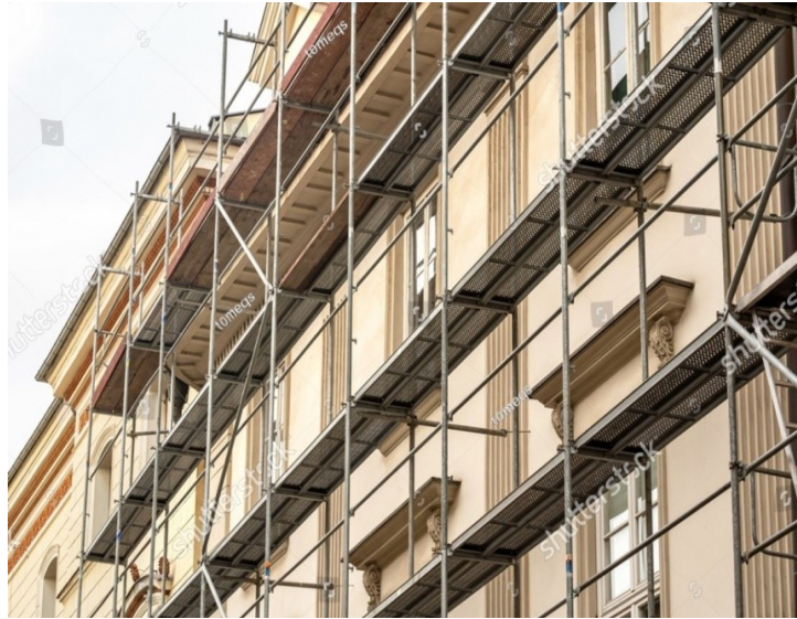
Εικόνα 110: Συνολική Ανακαίνιση κτιρίων
