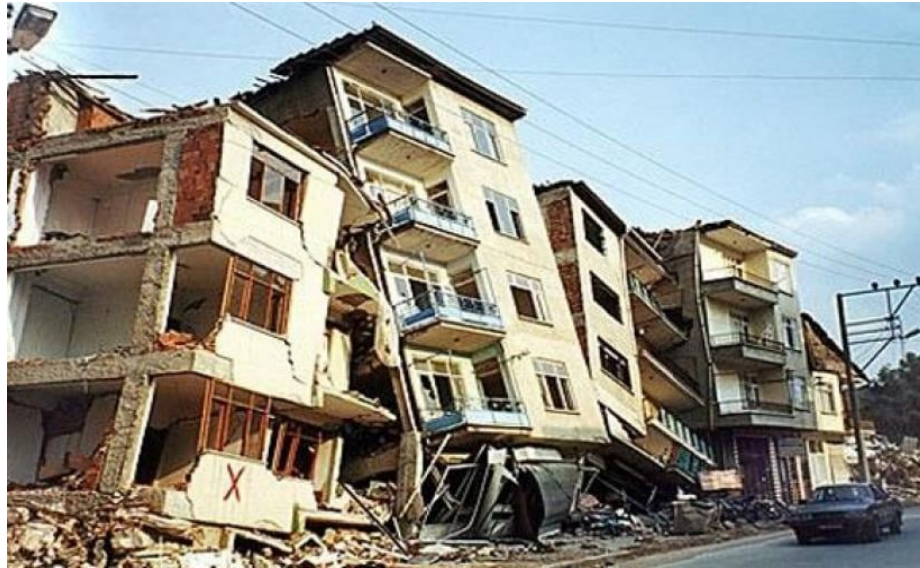
Εικόνα 155: Κτίρια μετά τον σεισμό της Πάρνηθας, 1999
