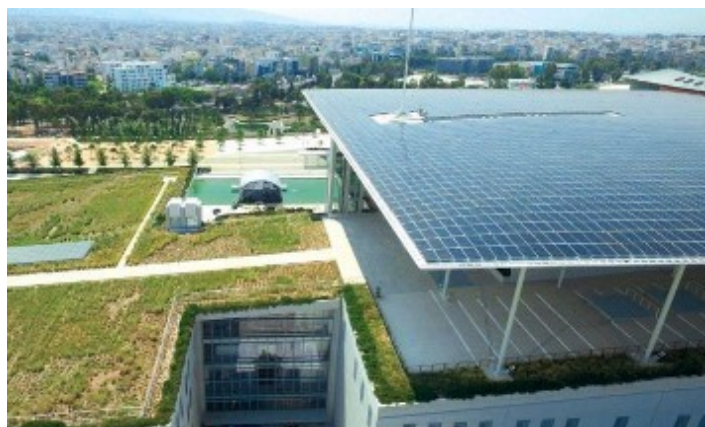
Εικόνα 129: Το ενεργειακό στέγαστρο του ΚΠΙΣΝ
