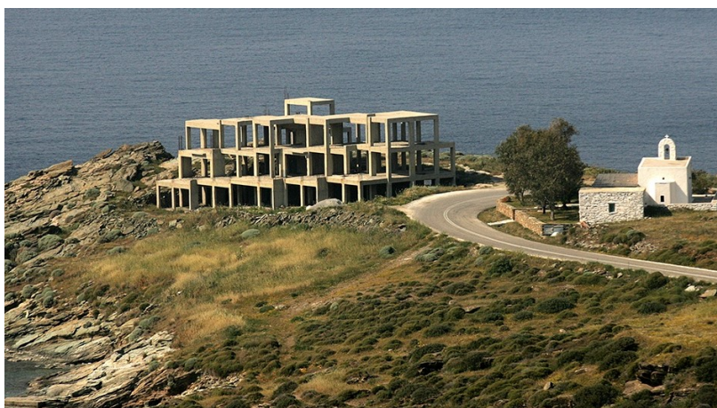
Εικόνα 120. Αυθαίρετες μεγάλες κατασκευές
