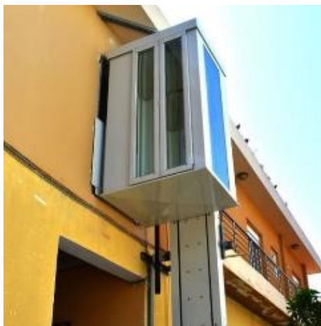
Εικόνα 80. Υφιστάμενο κτίριο προς προσαρμογή με νέα χρήση
