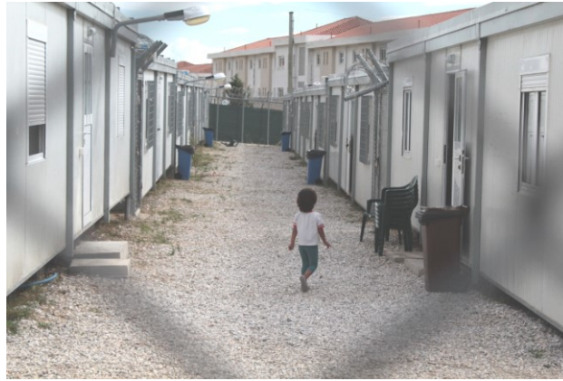
Εικόνα 108. Τοποθέτηση προκατασκευασμένων κατοικιών για την κάλυψη στεγαστικών αναγκών προσφύγων, με Έγκριση Εργασιών Δόμησης Μικρής Κλίμακας
