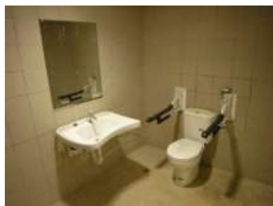
Εικόνα 72. Προσβάσιμος χώρος υγιεινής
