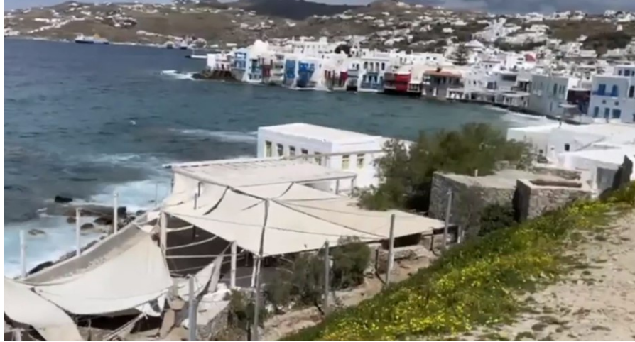
Εικόνα 124. Αυθαίρετες κατασκευές σε νησιωτικό οικισμό
