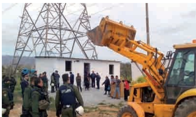
Εικόνα 123. Κατεδάφιση αυθαίρετης κατασκευής
