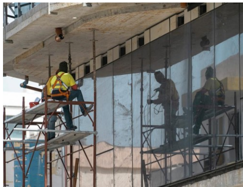
Εικόνα 112. Αντικατάσταση υαλοπετασμάτων όψης, με Έγκριση Εργασιών Δόμησης Μικρής Κλίμακας
