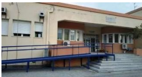
Εικόνα 38. Ράμπα παράλληλα στο κτίριο
