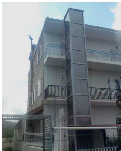
Εικόνα 109. Τοποθέτηση ανεγκυστήρα για την εξυπηρέτηση Εμποδιζόμενων Ατόμων, με Έγκριση Εργασιών Δόμησης Μικρής Κλίμακας
