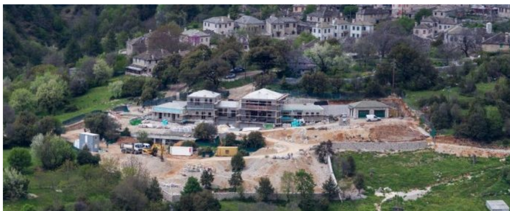
Εικόνα 121. Αυθαίρετες κατασκευές σε παραδοσιακούς οικισμούς
