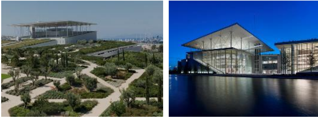
Εικόνα 149: Το κτίριο και το πάρκο του Κέντρου Πολιτισμού Ίδρυμα Σταύρος Νιάρχος (ΚΠΙΣΝ)
