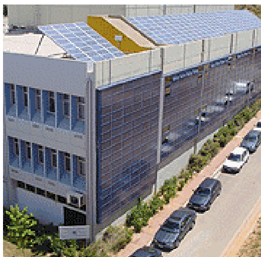
Εικόνα 176: Φωτοβολταϊκό σύστημα στην όψη της σχολής Χημικών Μηχανικών ΕΜΠ
