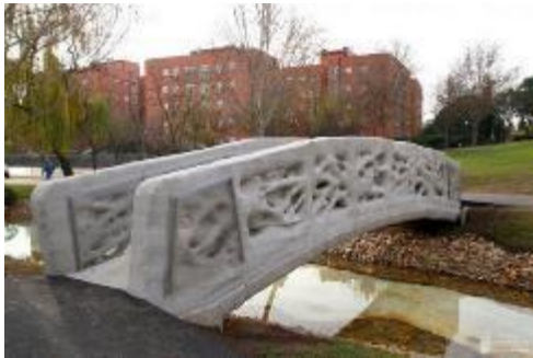
Εικόνα 204: Πεζογέφυρα κατασκευασμένη από 3d printer - Μαδρίτη Ισπανίας
