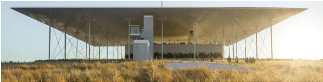
Εικόνα 151: Φυτεμένα δώματα στα κτίρια του ΚΠΙΣΝ
