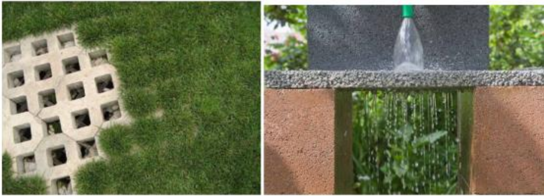
Εικόνα 231: Διάτρητες πλάκες που επιτρέπουν την φύτευση και υδατοπερατές επιφάνειες σκυροδέματος
