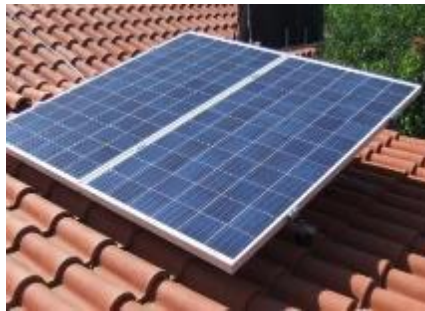
Εικόνα 144: Φωτοβολταϊκά πλαίσια για την παραγωγή ηλεκτρικού ρεύματος
