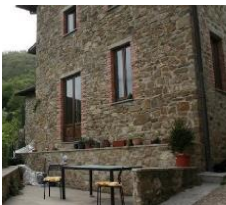
Εικόνα 130: Η πέτρα ως κύριο δομικό υλικό για την κατασκευή κτιρίου
