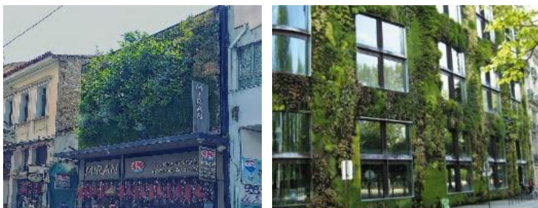
Εικόνα 127: Τυπική λεπτομέρεια σύνδεσης ξύλινης σχάρας με υφιστάμενη τοιχοποιία και παραδείγματα εφαρμογής φύτευσης όψης
