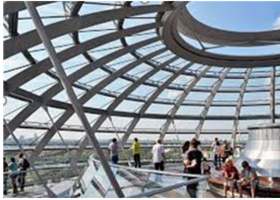
Εικόνα 95: Κτίριο Κοινοβουλίου (Reichstag) στο Βερολίνο. Αρχιτέκτων ανακαίνισης Norman Foster , 1999. Ο γυάλινος θόλος είναι επισκέψιμος από το κοινό.
