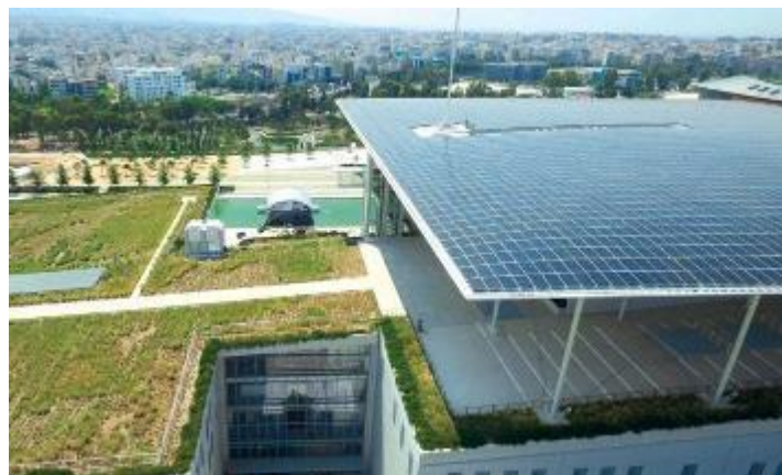
Εικόνα 152: Το ενεργειακό στέγαστρο του ΚΠΙΣΝ
