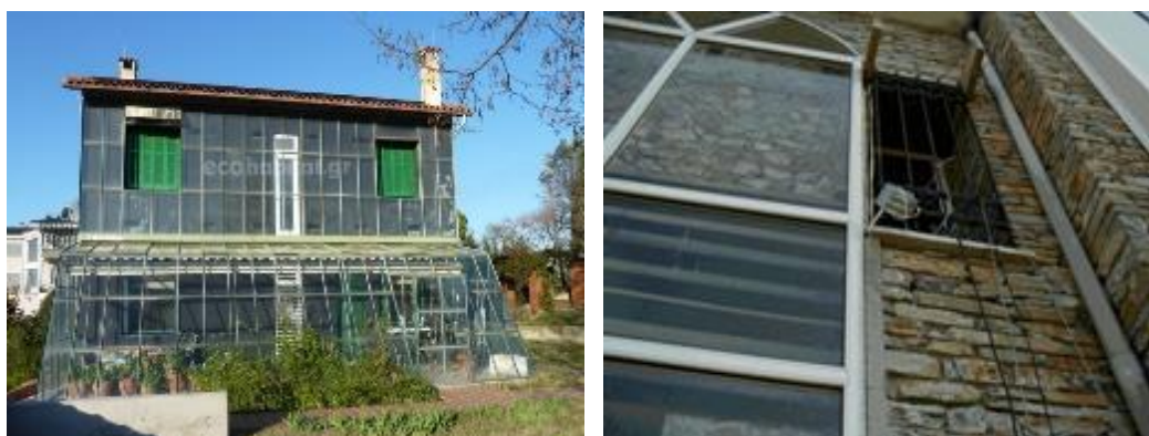
Εικόνα 103: Εφαρμογές τοίχου θερμικής μάζας
